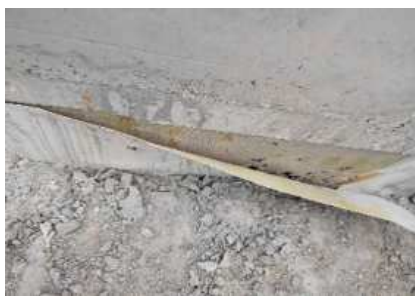
图 6.2.5-1、2 防水卷材与后浇混凝土粘接不合格
