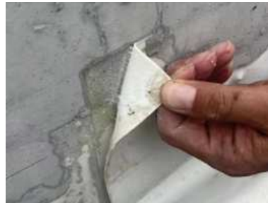
图 6.2.5-1、2 防水卷材与后浇混凝土粘接不合格
