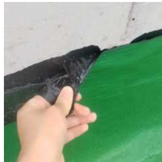
图 6.2.2-2 合格的非固化防水涂料与卷材粘接效果
