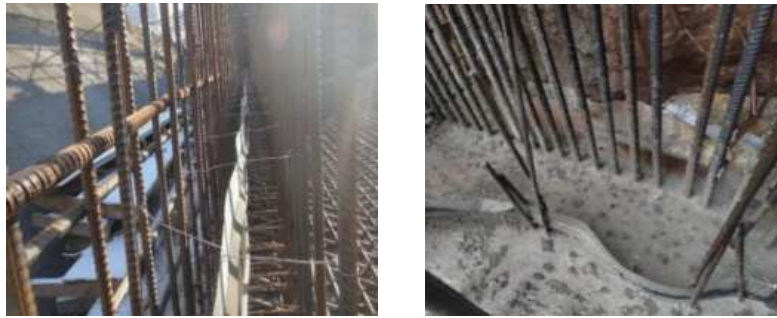
图 6.2.10-1、2 钢边橡胶止水带固定对比
